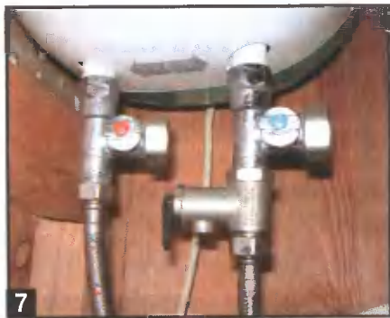
7 Трёхпроходные краны облегчают слив воды из электрического водонагревателя при подготовке к зиме.
