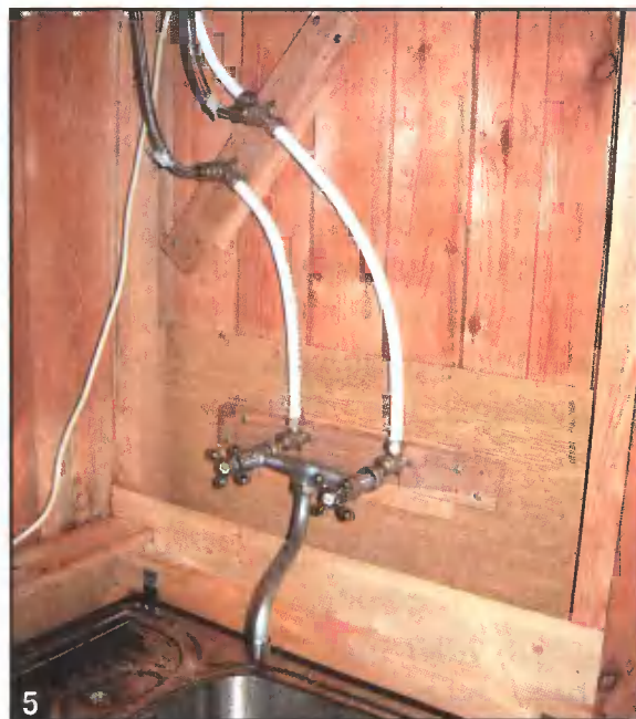
Фитинги закреплены на опорных брусках.
