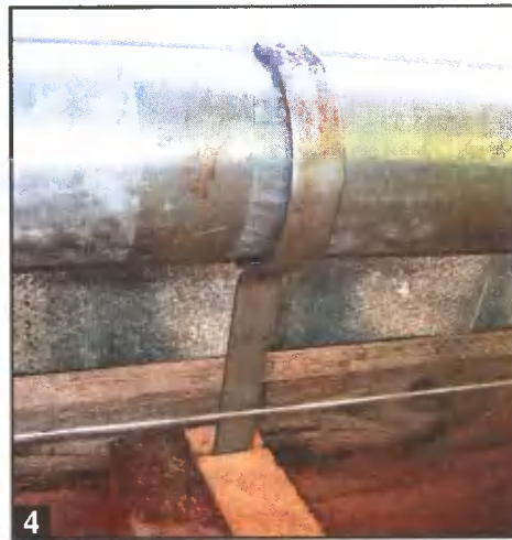
Плечо кронштейна надёжно зажато между «половинками» накладки.
