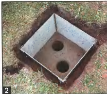
Этапы устройства кессона для слива воды.
