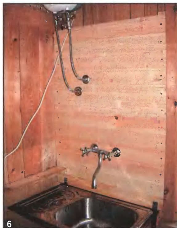
Внутренняя разводка в доме частично скрыта за вагонкой.
