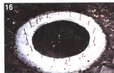
Перед заливкой железобетонного «ножа» в выкопанную на глубину 300...350 мм траншею следует уложить пленку, а затем установить арматуру с выпусками для связи со стенками колодезного кольца.
