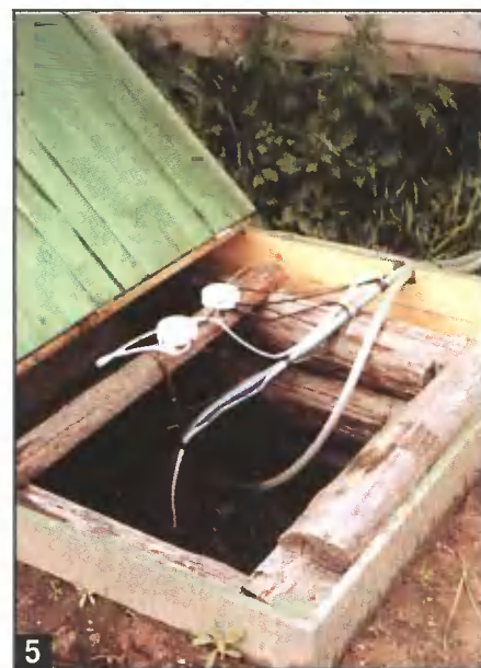
Оголовок колодца. Хорошо видны ответственные коробки для подвода электропитания к насосу «Малыш» и снятия сигналов с датчиков уровня воды в колодце.
