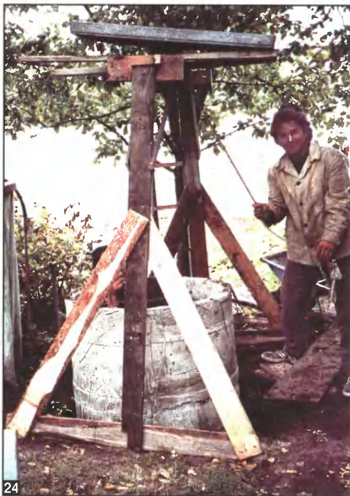
24 Во время установки секции она постоянно наклонялась, но благодаря зазору между грунтом и бетонной поверхностью её ни разу не заклинило.
