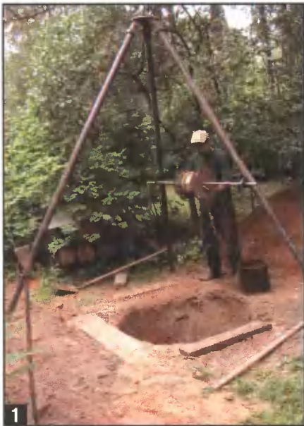
1 Для поднятия бадьи с грунтом на треногу устанавливают ворот – ось с барабаном и рукоятью.
