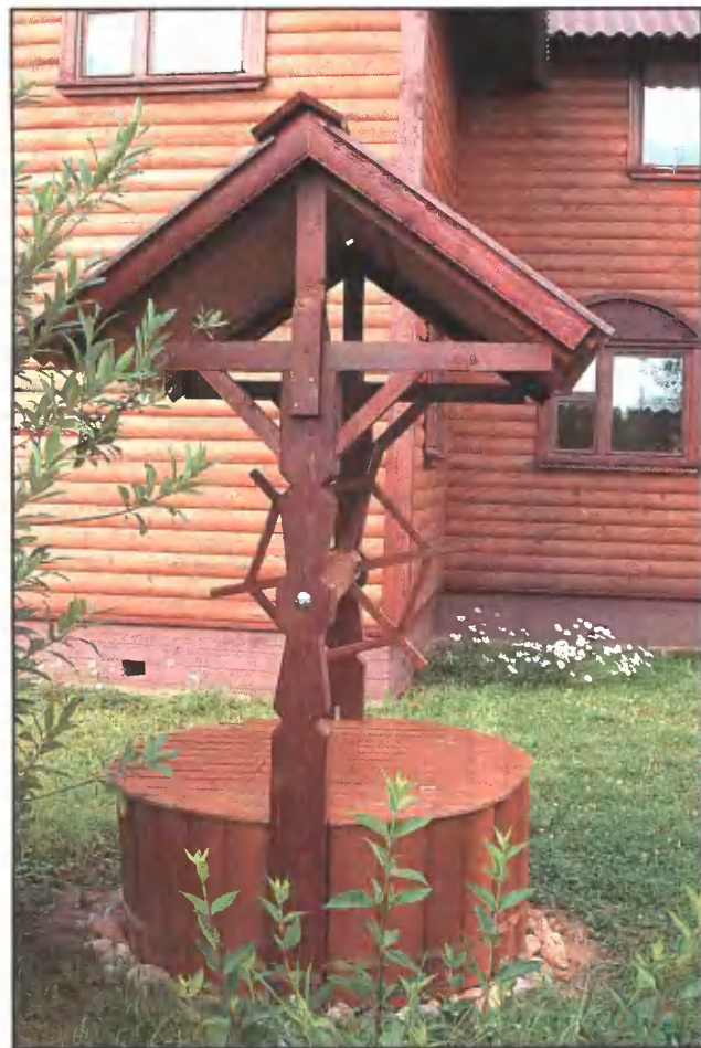
Переоборудованный колодец не только отвечает всем санитарным требованиям, но и соответствует стилю нашего дачного участка.
