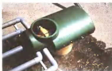
6 Автоматический регулятор улучшает распределение выходного продукта при разливе его в систему подземных труб.
