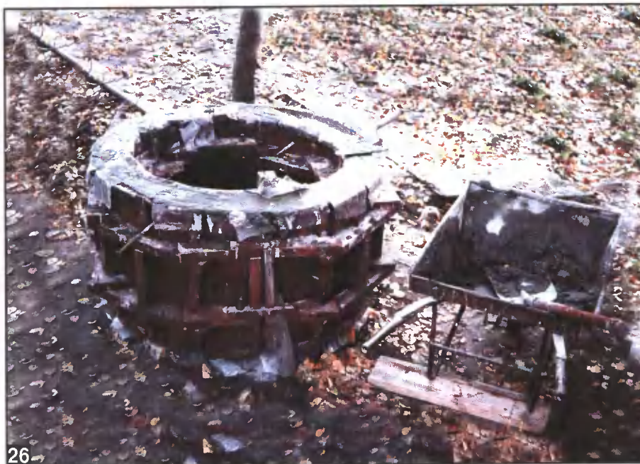
Рис. 4. Сборный железобетонный колодец с «ножом».
