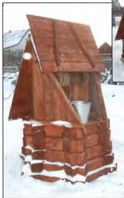
Колодезный домик из досок и брусьев позволяет эксплуатировать колодец круглогодично. Сруб выполнен в виде шестигранной усечённой пирамиды. Между венцами проложен утеплитель.
