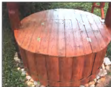
Обшивку оголовка прикрепили к оголовку саморезами и стянули латунной лентой.
