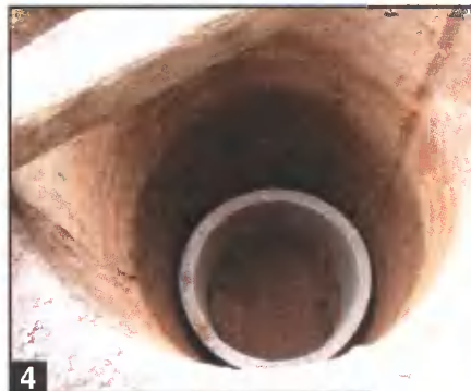
4 После проходки шахты до уровня водоносного слоя опускают первое кольцо.
