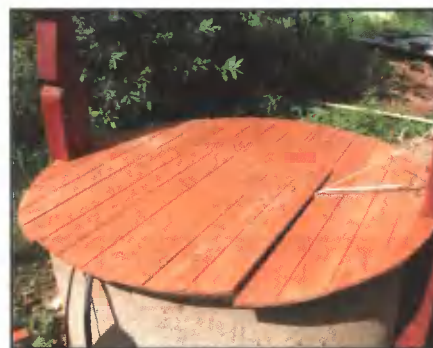
Сверху колодец закрывается двумя створками на петлях.
