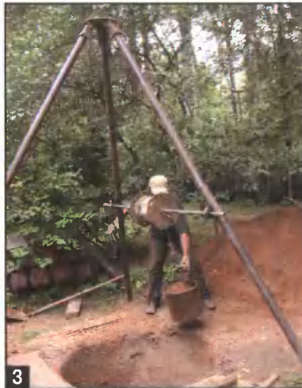
3 При подъёме очень тяжёлой бадьи или человека цепь наматывают непосредственно на ось.
