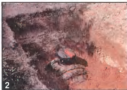
2 Ширина котлована под цистерну должна быть по меньшей мере на 60 см больше диаметра цистерны, чтобы её было удобнее устанавливать.
