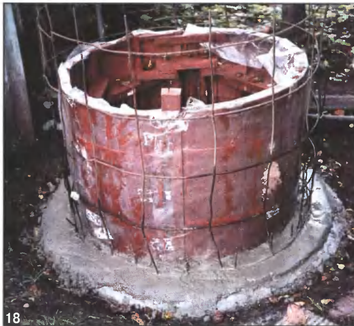
18 Внутренний цилиндр опалубки установлен на железобетонный «нож» по слою пескобетона. После монтажа арматуры можно устанавливать наружный цилиндр.
