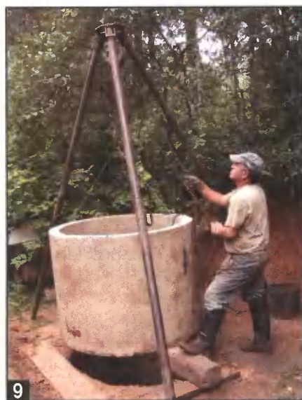
9 Чтобы опустить кольцо в колодец, его сначала надо приподнять и убрать опорный брус.
