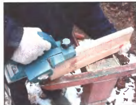
Шпунты досок блокхауса пришлось снять рубанком.
