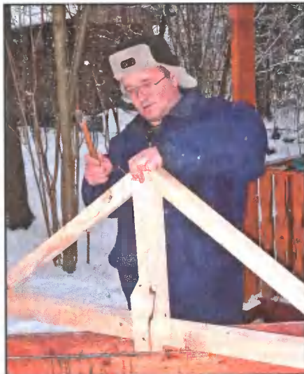
Все элементы нашего сооружения собраны на саморезах и гвоздях.
