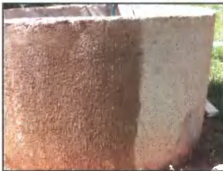
Чтобы оголовок не отдавал влагу деревянной обшивке, его покрыли водонепроницаемой грунтовкой.
