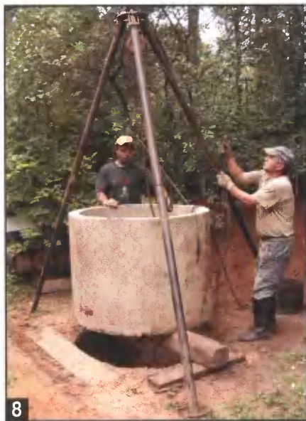
8 Закреплённое за отверстия в стенках кольцо подвешивают с помощью троса на блоке полиспаста.
