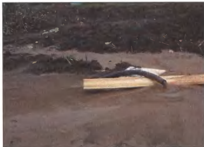
Но с монитором характер работы резко изменяется — насос довольно легко поднимает на поверхность насыщенную песком пульпу.
