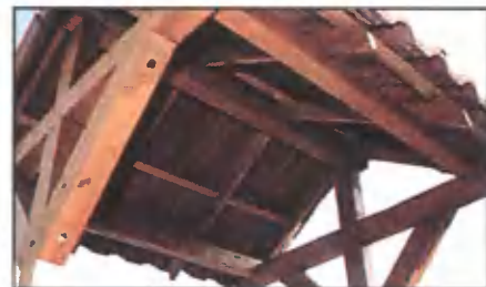
Конструкцию навеса с черепичной кровлей не назовешь простой.
