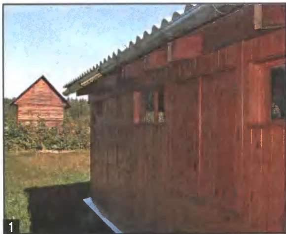
Даже при неравномерном шаге между стропилами водосливный желоб установлен с плавным перепадом высоты.
