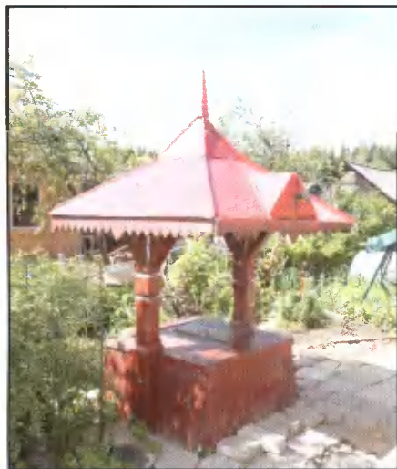
Над колодцем сооружён навес с кровлей, соответствующей кровле дома. Оголовок колодца выполнен из досок толщиной 50 мм. Отмостка — бетонные плитки.
