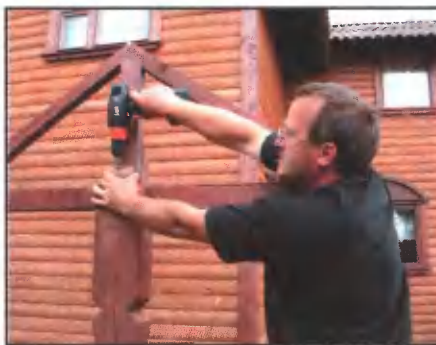
Стропила установили на опорные столбы и прикрепили на саморезах металлическими уголками
