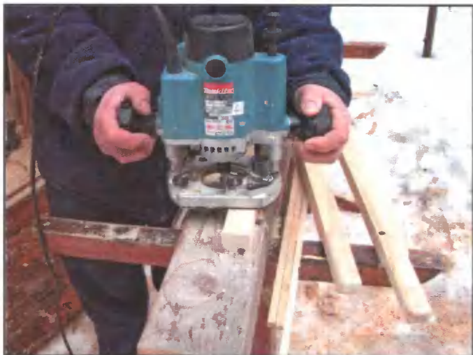
Концы ручек обработали ручной фрезерной машинкой.
