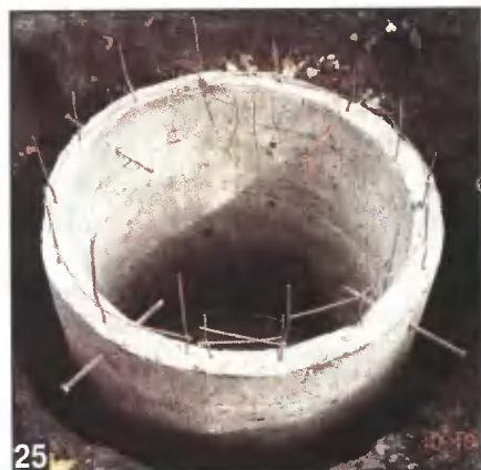
Рис. 4. Сборный железобетонный колодец с «ножом».
