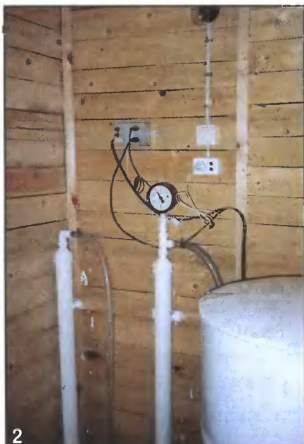
Водонапорная ёмкость и фильтры очистки воды. Для контроля за давлением сети на фильтр грубой очистки установлен манометр.
