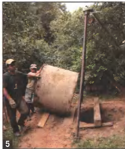
5 Для удобства перемещения тяжёлых (около 800 кг) бетонных колец из уплотнённого грунта устраивают «сортировочную» горку.
