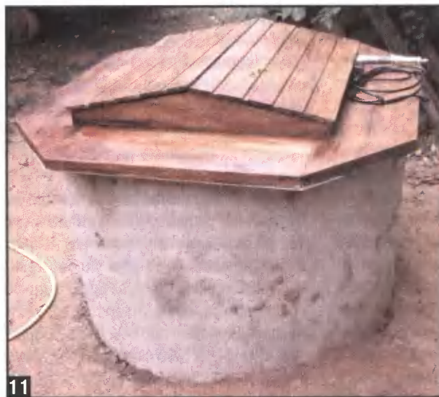
11 На крышке предусмотрен патрубок, к которому можно подсоединить поливочный шланг.
