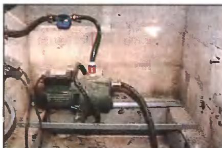
Насос включается автоматически при открытии разборного крана.
