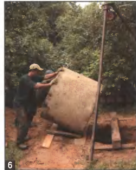
6 Закатив кольцо на такую горку, его кантуют на прочный брус, положенный над колодцем.
