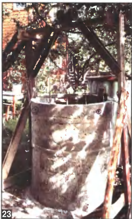
23 Рама с блоком для подъёма ведер с грунтом установлена — можно опускать в грунт первую секцию колодца.
