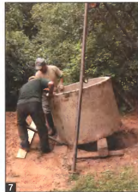
7 Положение кольца перед подъёмом корректируют с помощью рычага.
