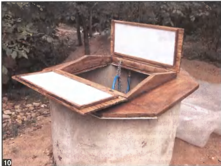
10 При открытых створках видны ввёрнутые в крышку крюки для подвешивания насоса и подающего шланга.
