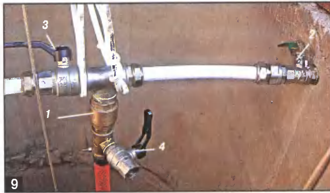
9 Узел разбора воды с дополнительной функцией осеннего водоснабжения: 1 — обратный клапан; 2 — наружный кран; 3 — кран отсечения летнего водопровода; 4 — кран для продувки обратного клапана.
