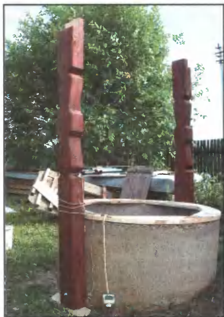
Столбы к оголовку прикрепили резьбовыми шпильками.
