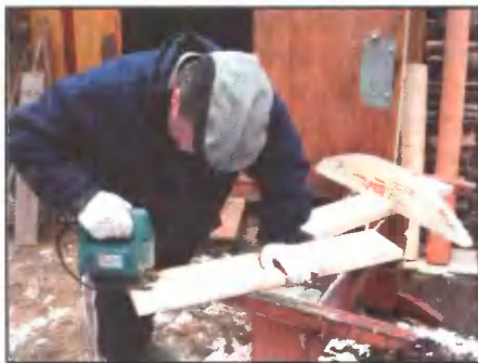
Крышку оголовка колодца собрали из выпиленных лобзиком заготовок.
