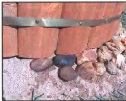
«Цоколь» колодца отсыпали камнями.
