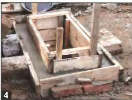
4 Бетонирование стенок приямка.
