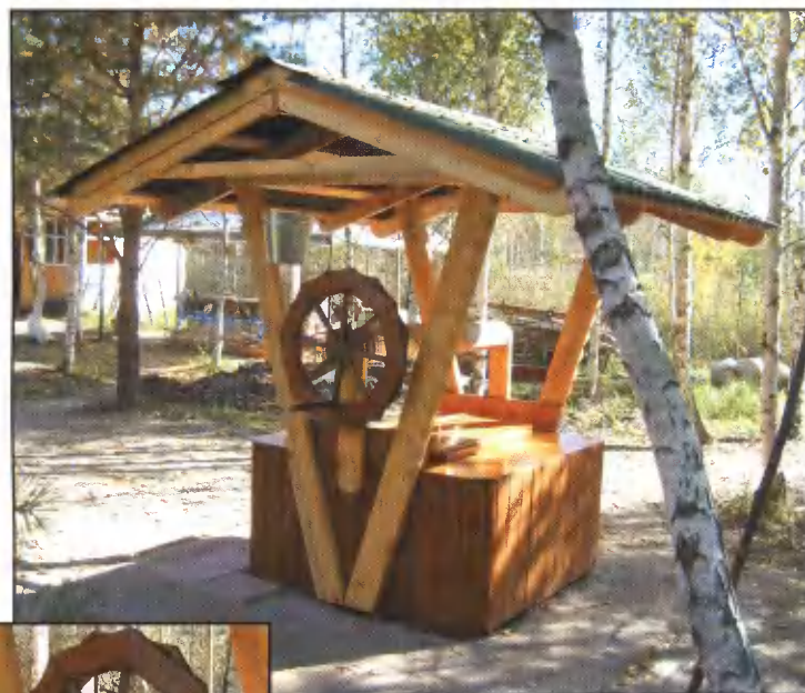
Своеобразный штурвал на ворота колодца свидетельствует о «морской душе» хозяина участка. Обратите внимание, «штурвал» сделан из одинаковых трапециевидальных отрезков строганых досок, которые соединены в два слоя.
