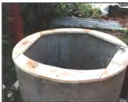
Заготовленные ещё зимой детали круглого кольца оголовка собрали и скрепили с помощью деревянных уголков на саморезах.
