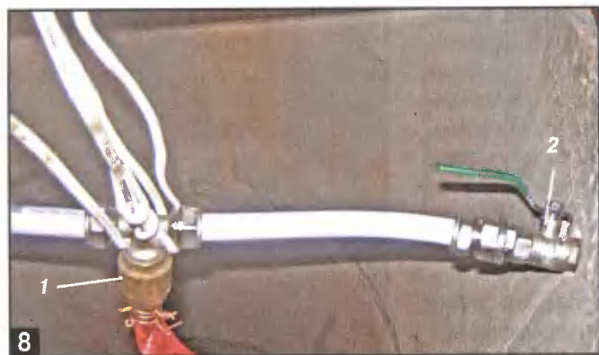
8 Первоначальный узел разбора воды из колодца: 1 — обратный клапан; 2 — наружный кран.
